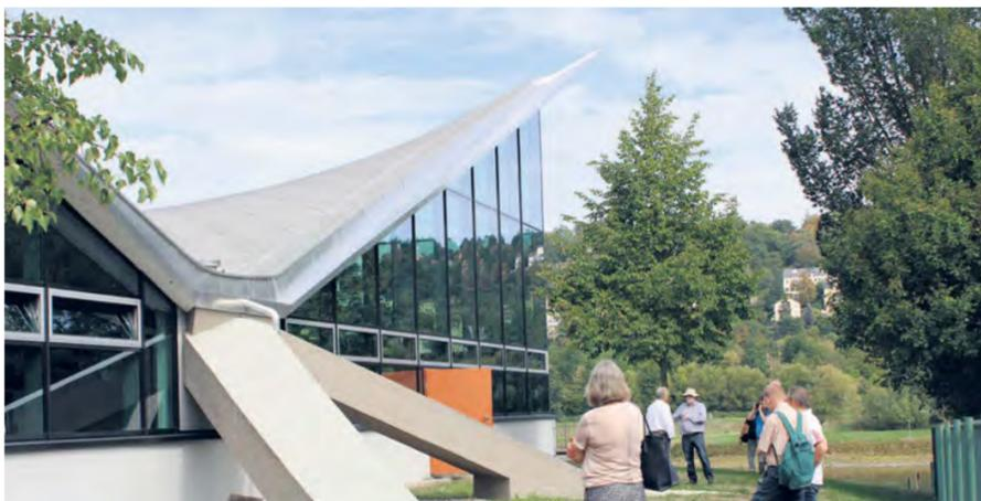
Neben dem gefalteten Dach fallen beim Wassersportzentrum auch die markanten schrägen Betonstützen auf, die die Lasten der selbsttragenden Stahlbetondecke abfangen. Foto: Pohl
