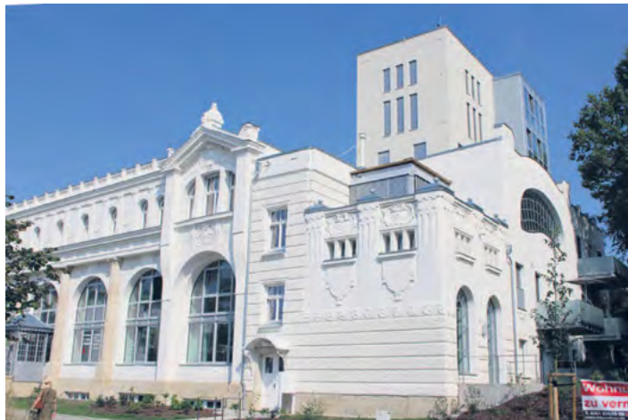
Der Dr. Lahmann Park besticht durch hochwertig sanierte Altbauten wie hier das „Herrenbad“ und moderne Wohngebäude. Foto: Pohl
