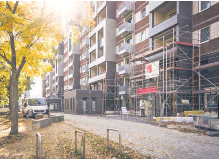
Modernisierung an der Offenburger Straße.
