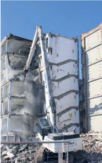
Im März 2016 begann der Abriss der ersten Robotron-Gebäude. Damit wurde Baufreiheit für die „neue Lingnerstadt“ geschaffen. Foto: Pohl
