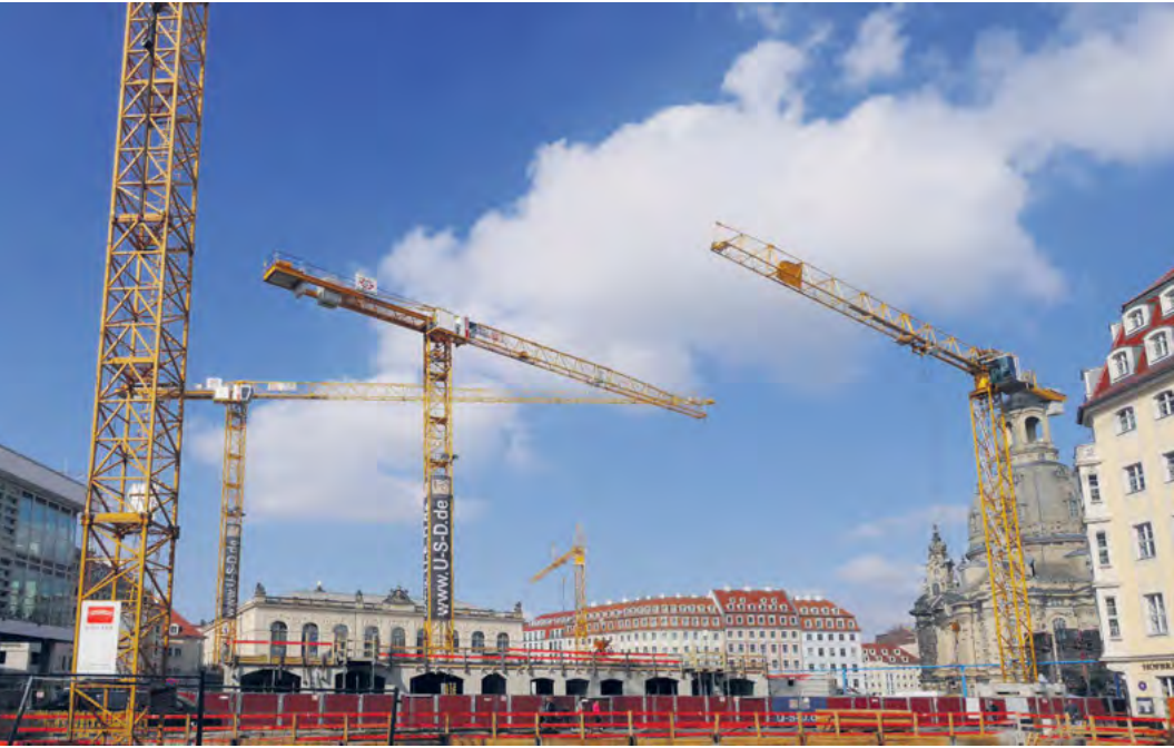
Großbaustelle Neumarkt in Dresden: Zwischen Kulturpalast (l.) und Heinrich-Schütz-Haus (r.) drehen sich die Baukräne. (mehr auf Seite 3)
