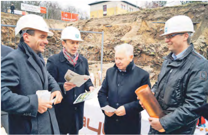
Zur Grundsteinlegung wurde im Beisein von Berndt Dietze (2.v.r.), Geschäftsführer der Baywobau Dresden, eine Kapsel mit Dokumenten versenkt. Mit dabei: Teamleiter Steffen Hauschild, Baywobau, Niederlassungsleiter Jörg Muschol und Oberbauleiter Christian Fuhrmann von Dreßler Bau Dresden. Foto: Romy Linné
