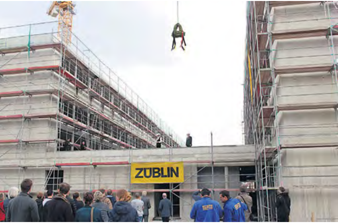
Der Rohbau steht: Zum Richtfest gab es viel Lob und ein großes Dankeschön für alle am Bau Beteiligten. Foto: Pohl
