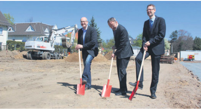
Vollzogen den 1. Spatenstich: Axel Walther, Bürgermeister Peter Lames und Andreas Hemmersbach (v.l.n.r.). Foto: Pohl
