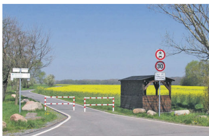
Schutzhütte am Mulde-Rad-Weg Ortsausgang Kollau.
