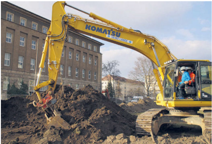
Harald Hohmann vom Bauunternehmen Heinz Lange und der zehnjährige Enkel des Geschäftsführers der AWV-Gruppe Raphael Kahle saßen am Steuer beim ersten Baggeraushub. Foto: Dietrich
