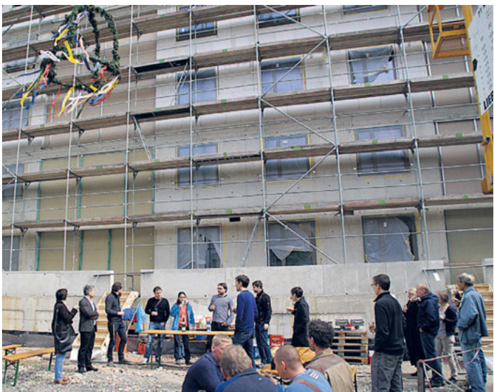
Geselliges Zusammensein beim Richtfest. Foto: Steffen Dietrich
