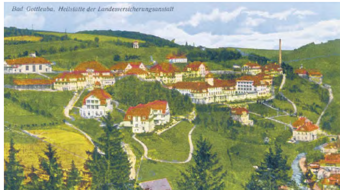
Gesamtansicht der Anlage auf einer historischen Postkarte.
