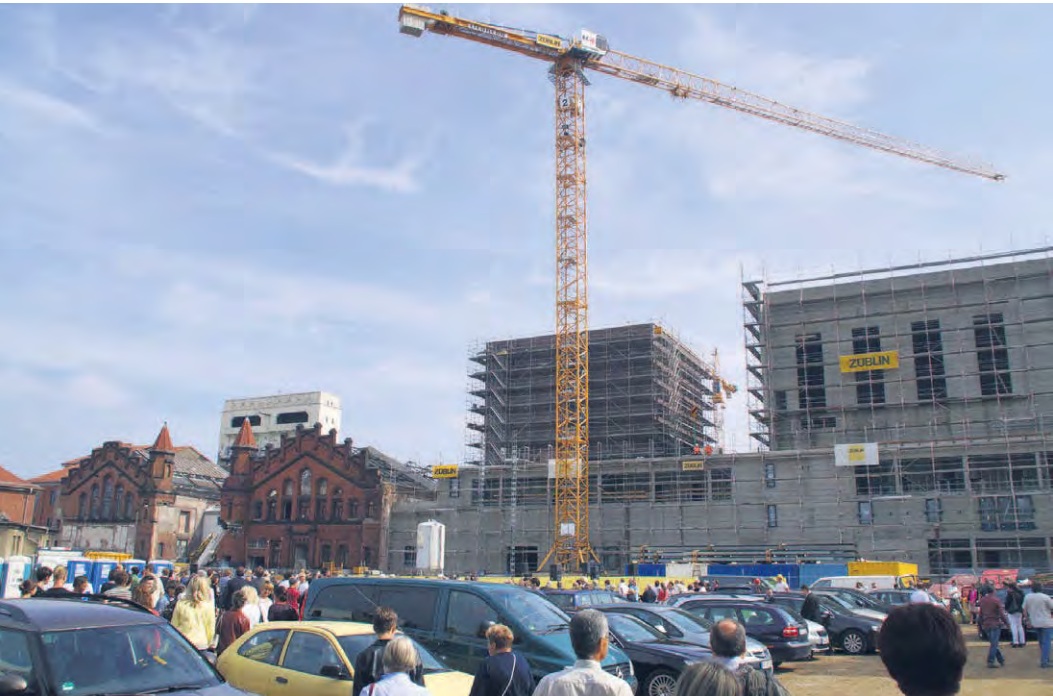
Am 20. September wurde Richtfest auf der Theaterbaustelle Kraftwerk Mitte gefeiert. Hier entsteht das neue Zuhause für die Staatsoperette Dresden und das tlg. theater junge generation. Die Baukosten belaufen sich auf 91 Millionen Euro. 9,3 Millionen Euro hat der Stadtrat zusätzlich bewilligt für die Modernisierung der Ausstattung beider Theater. Ende 2016 soll hier Premiere gefeiert werden. Foto: Dietrich
