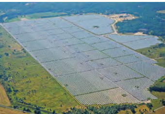
Zum Zeitpunkt der Inbetriebnahme war die Photovoltaikanlage in Waldpolenz die weltgrößte. Foto: juwi AG
