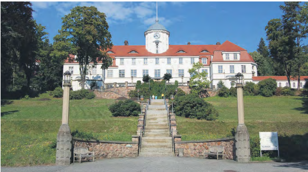
Das Kurmittelhaus – zentrales Gebäude im MEDIAN-Gesundheitspark Bad Gottleuba.
