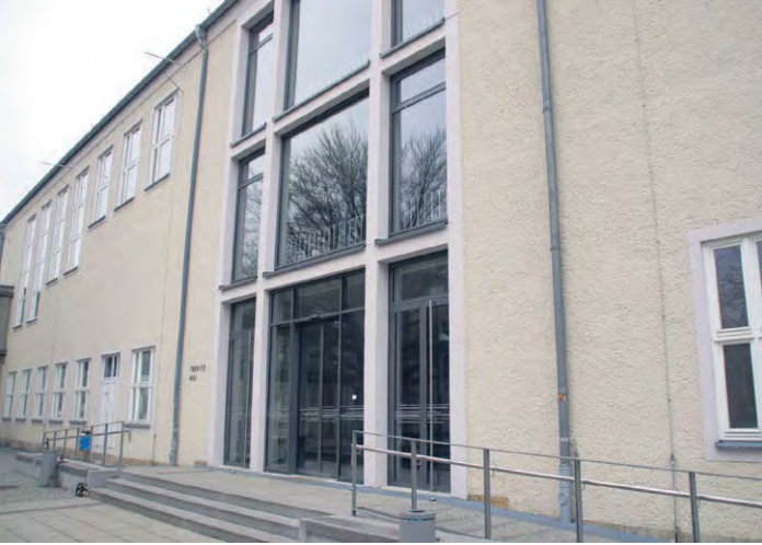
Die letzten Arbeiten für das Physikgebäude der TU Dresden wurden Ende Januar abgeschlossen. Foto: Dietrich
