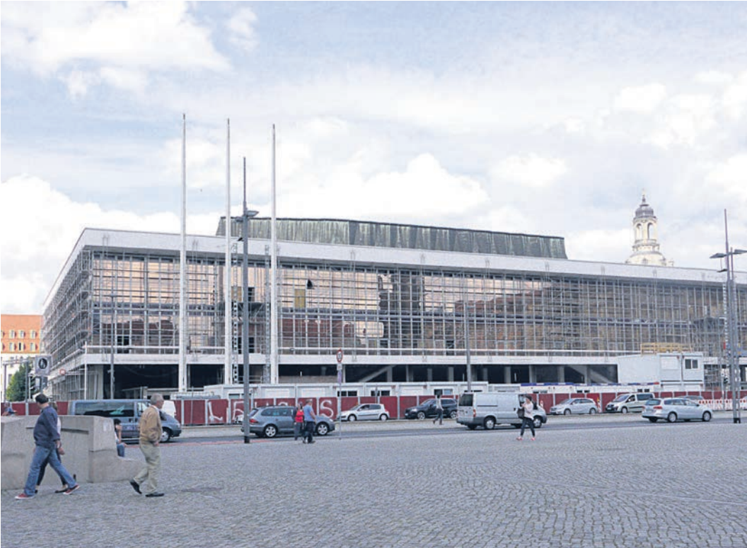
An der Fassade ist bereits das umlaufende Gerüst zu sehen. Ab Mitte Juli hängen daran Plänen mit Bildern vom „neuen“ Kulturpalast.
