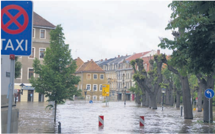
Die Innenstadt von Pirna verwandelte sich beim Junihochwasser 2013 in eine Flusslandschaft. Bis Ende 2016 sollen die Schäden behoben sein.
