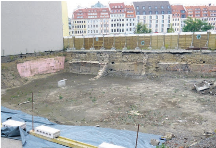
Der Grundstein für das „Frieseneck“ ist gelegt.
