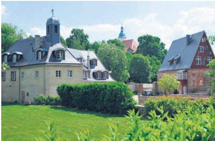
Einige Gebäude auf dem Schlossgelände sind zu neuem Leben erwacht. Vom Schloss selbst zeugen nur Trümmersteine. Foto: privat
