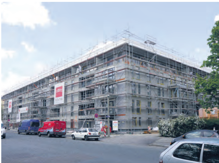
An der Wallotstraße in Striesen verwirklicht die WG Aufbau ihr erstes großes Neubau-Projekt: ein Mehrfamilienhaus mit 56 barrierefreien Wohnungen. Im September 2014 soll es fertig sein. Foto: Graf
