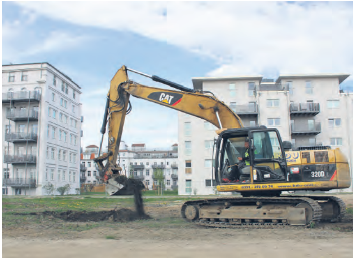
Erster Baggerbiss für ein neues Wohnquartier in Dresden-Striesen Anfang April 2014. Hier werden über 180 neue Eigentumswohnungen entstehen. Foto: Pohl
