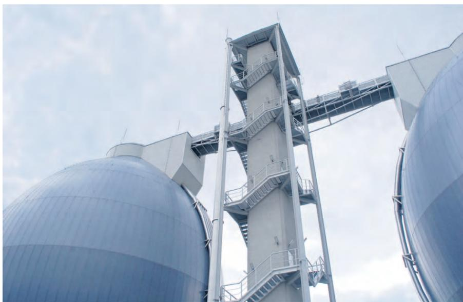
Am 27. April kann ab 10 Uhr die neue Schlammbehandlungsanlage in Dresden-Kaditz besichtigt werden. Hier produziert die Stadtentwässerung Dresden (SEDD) aus Klärschlamm Energie. Das Klärgas entsteht in zwei 35 Meter hohen Fauleiern. Foto: Möller
