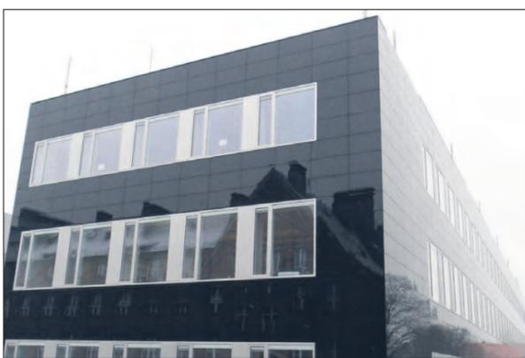
Bei der Sanierung des Walther-Hempel-Baus der Technischen Universität Dresden wurde in die Fassade eine Photovoltaikanlage integriert. Foto: Dietrich
