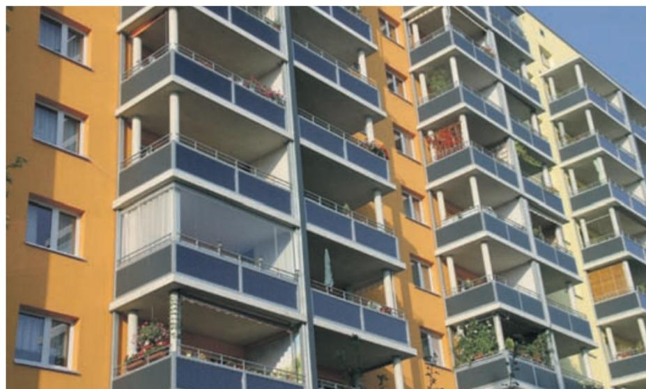
In den Balkonen der Hans-Marchwitza-Straße 14-20 befinden sich solarthermische Anlagen, mit deren Energie rund ein Fünftel des warmen Wassers erzeugt wird.
