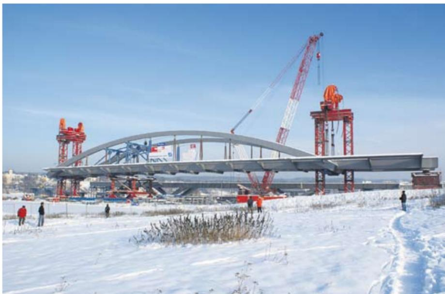
**Herausforderung beim Bau der umstrittenen Waldschlösschenbrücke: Der fertig montierte Brückenbogen auf der Altstadtseite wurde am 3. Dezember mit Hilfe zweier Litzentürme auf zehn Meter Höhe angehoben und auf einem fahrbaren Verschiebschlitten abgesetzt. Damit wurden die Voraussetzungen geschaffen, den Bogen in Richtung Fluss zu bewegen. Inzwischen wurden die Türme wieder entfernt, da sie das Verschieben der Brücke behindert hätten.** Foto: Simmert.
