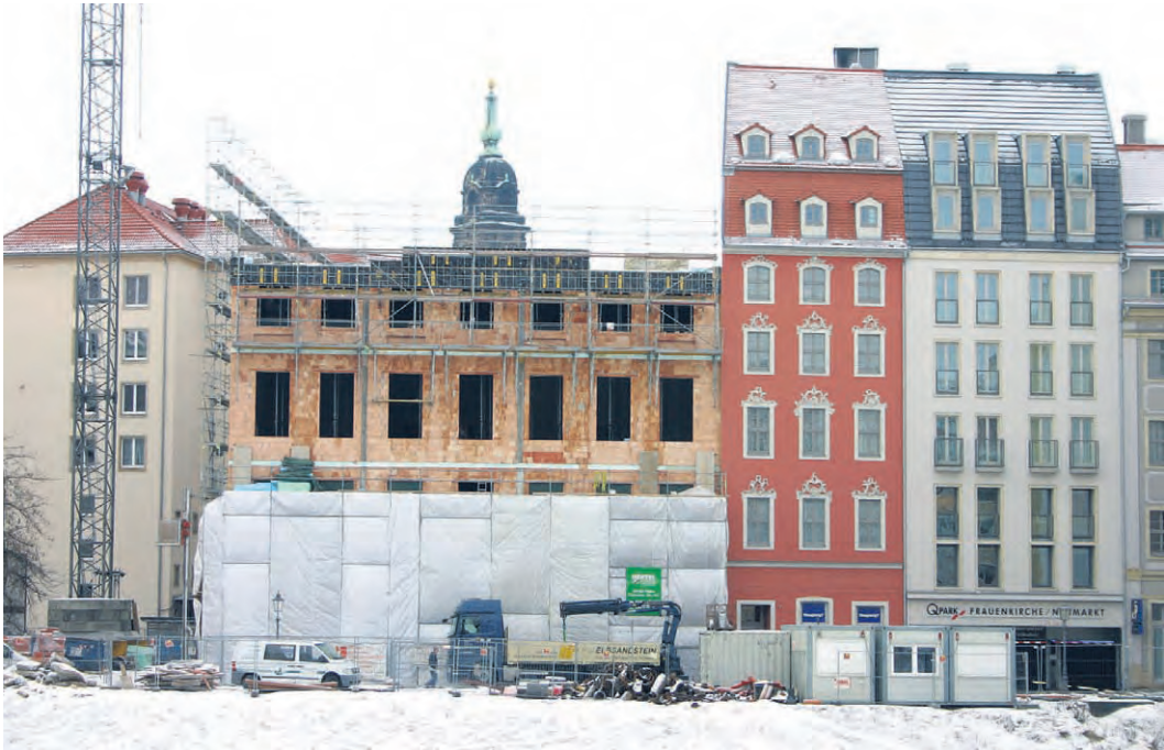
Am eingerüsteten künftigen British Hotel (links neben dem schmalen rotbraunen Rokokohaus) wird weiter gearbeitet, das Dachgeschoss ist bereits erreicht.
