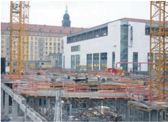
Blick auf die Baustelle, rechts die bestehende Altmarkt-Galerie.
