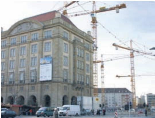
Rechts neben dem denkmalgeschützten Intecta-Gebäude entsteht der Neubau für die Galerie.
