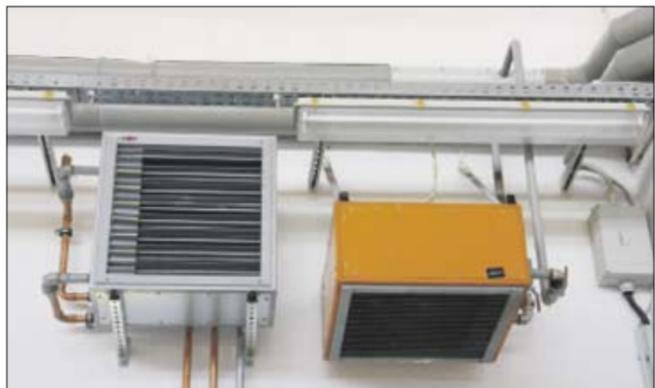
Wärmeverbraucher: Über Luftherhitzer wird die Industriehalle erwärmt. Die Last entspricht etwa der eines Einfamilienhauses.
