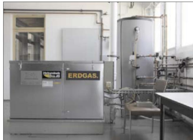
Das VNG-Mikro-BHKW bewährt sich im Dauertest in den Hallen des Erdgasspeichers Bad Lauchstädt. Bilder (4): PNR
